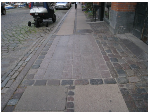
Figur 1: Brostenoverkørsel med 2 rækker bordursten og savede og jetbrændte chaussésten i mellem.
