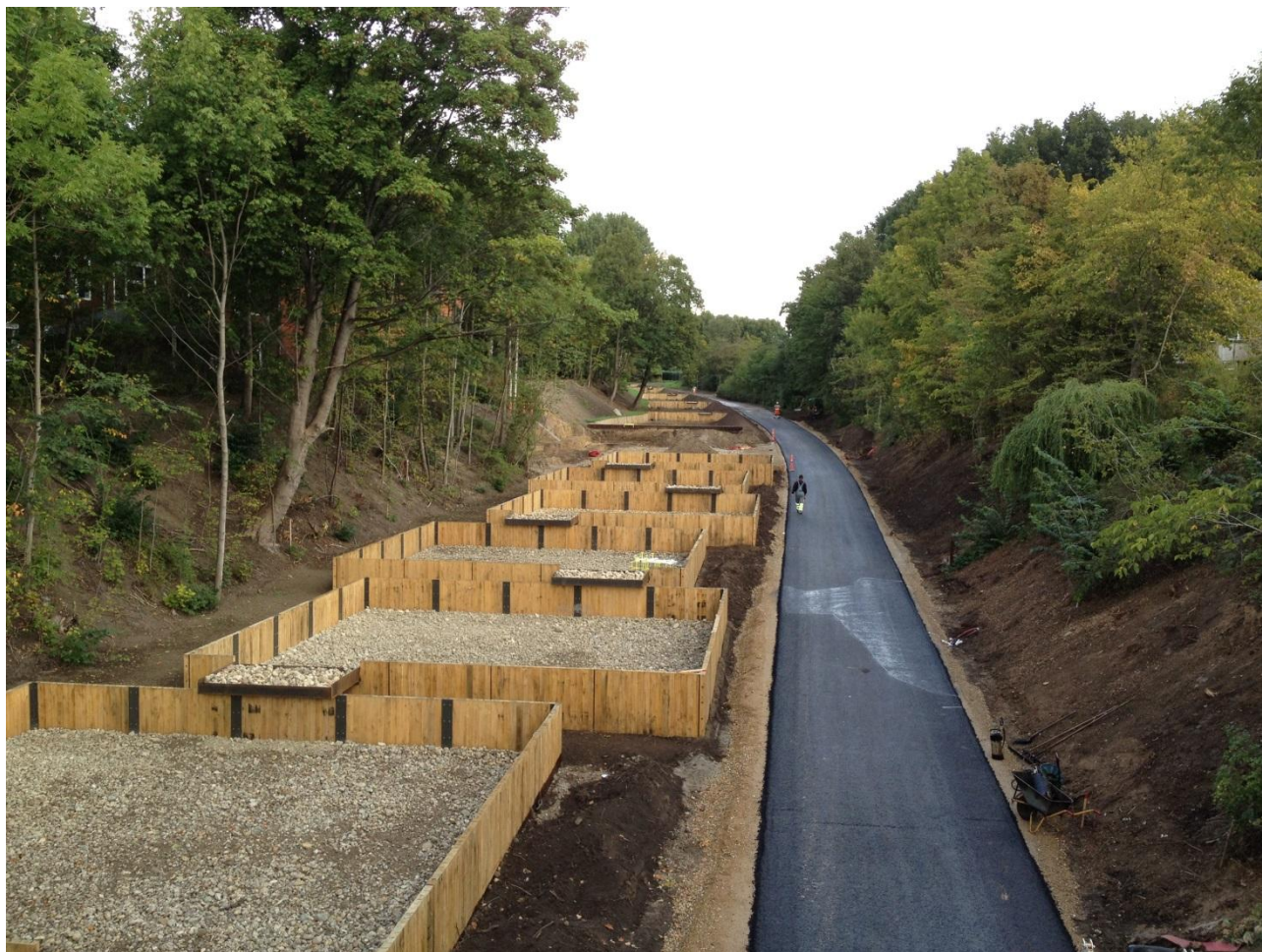
Figur. Et areal der oprindeligt var udlagt til en vej, som aldrig blev bygget, er blevet forvandlet til en hovedcykel/gangsti, og ca. 4000 m 3 regnvandsbassiner, som er udformet således at den rekreative værdi er høj.
