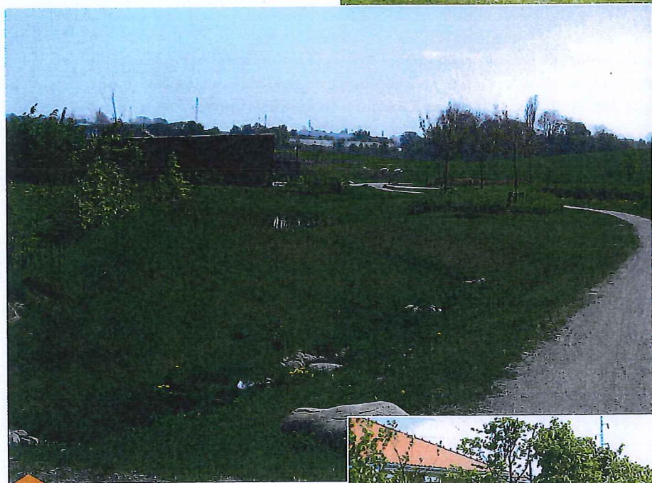
Figur 2. Hovedrenden opsamler regnvand fra veje og grønne områder og løber gennem det ovale bassin med dunhammer til via det store bassin bagerst på fotoet, før det når søerne.
