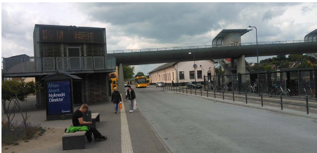
Figur 1. Ved den nye ITS trafikterminal ved Næstved station, giver stibro direkte adgang til togperroner, busholdepladser og centralt placeret cykelparkering (bl.a. aflåst cykelparkering i to etager centralt på terminalen). De gode muligheder for cykelparkering medfører, at næsten ingen cykler henstilles uden for stativerne. Foto: Via Trafik.
