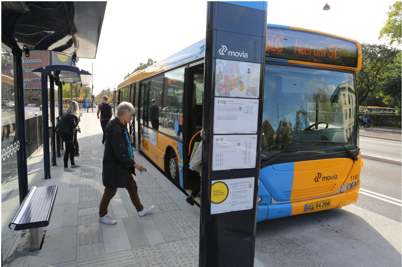
Figur 3: God plads og let ind- og udstigning ved stoppesteder er med til at forbedre busdrift og passagerkomfort. Her ved et superstoppested med 17 cm høj specialkantsten – en løsning, der bl.a. beskrives i den nye terminalhåndbog med inspiration fra andre europæiske lande. Foto: Via Trafik.
