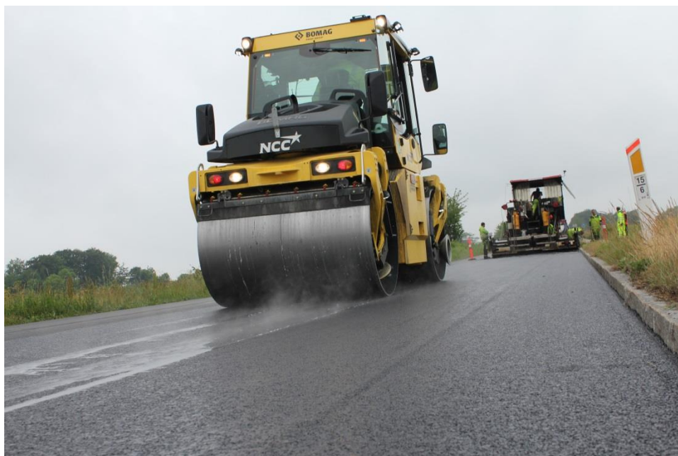
Figur 1. Udlægning af forsøgsstrækning hovedlandevej 619, ved Kalvehave
