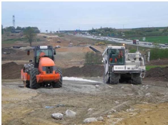
Figur 1. Venstre: Kalkstabilisering i marken ved indbygning Højre: Stabilisering på værk
