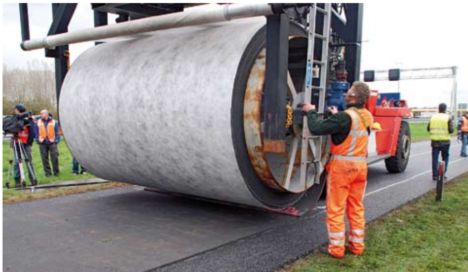
Figur 4. Udlægning af et fabriksfremstillet poro-elastic slidlag rullet op på en tromle.
