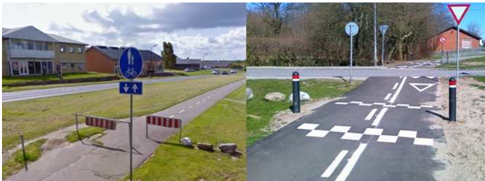
Figur 1 Det tidligere anlæg med stibomme (t.v.) og det nye anlæg med bump (t.h.)
