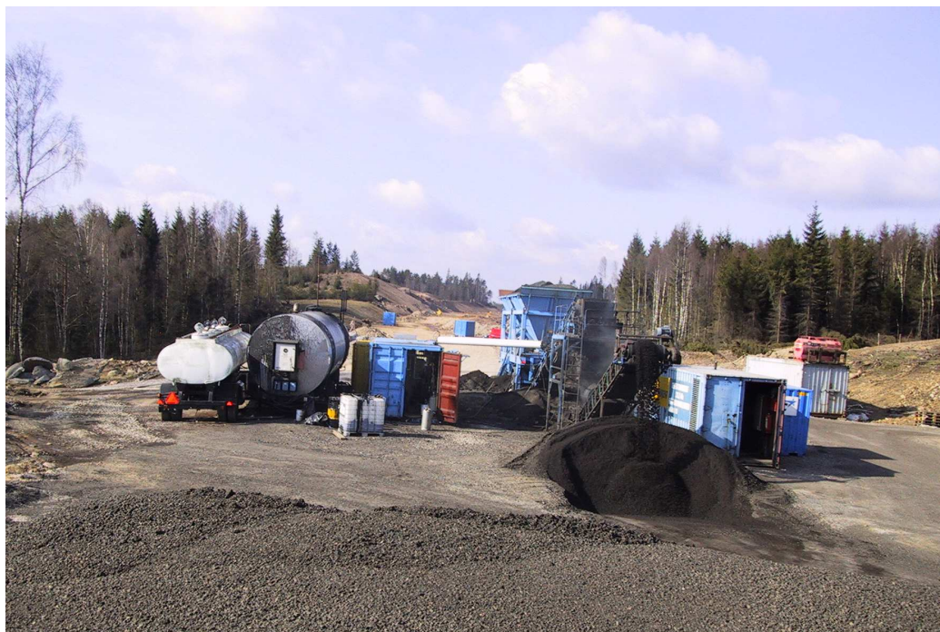
Figur 1. Produktion af skumbitumenstabiliseret tjæreholdigt genbrugsasfalt på E4 ved Markaryd.
