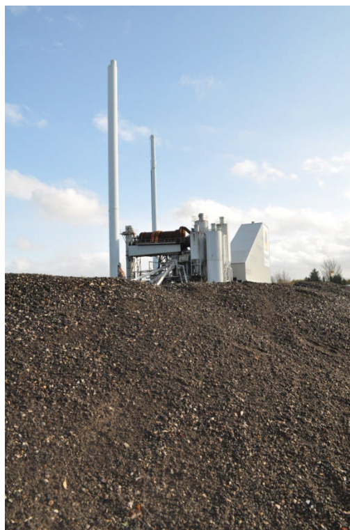
Gammel asfalt kan genbruges på fabrikkerne, men der må være balance mellem tilførsel og asfaltproduktion
