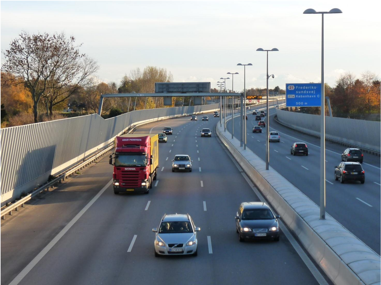
Der er anvendt støjreducerende asfalt på hele strækningen.
