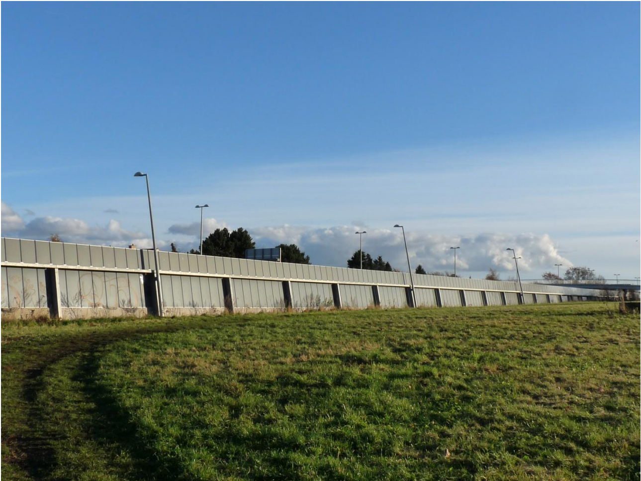
Der er i alt udført 17 km støjskærm i forbindelse med udvidelsen af M3.
