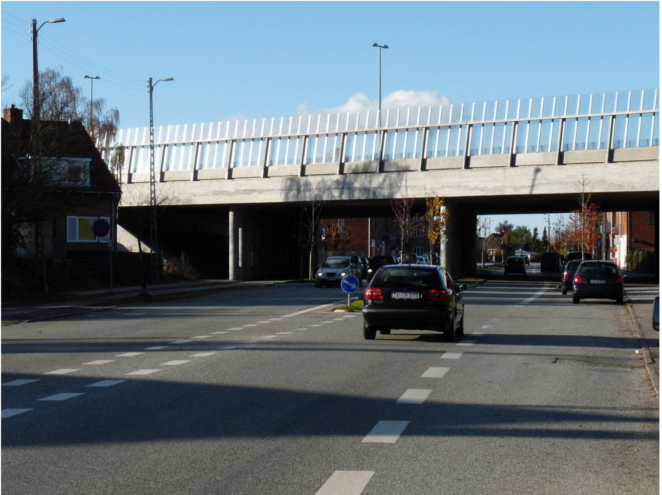
Gennemsigtig støjskærm på en motorvejsbro, der benyttes for at broen skal virke mindre massiv.
