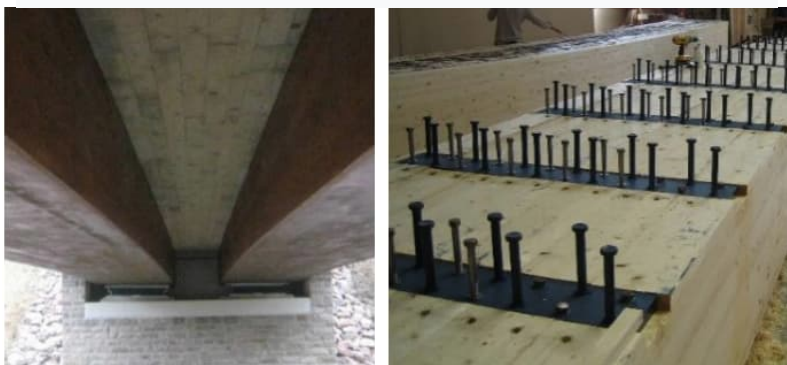
Birkberg Bro i Wippra, Tyskland, bygget med dyveler med hoveder (IB-Miebach, 2018)
