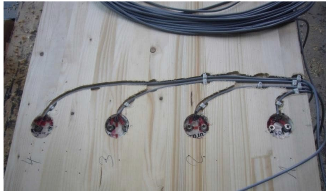
Fugtsensorer i træ (Ingenieurbüro Miebach (2018) Holz-Beton-Verbundbrücken - Erfahrungen und Perspektiven)
