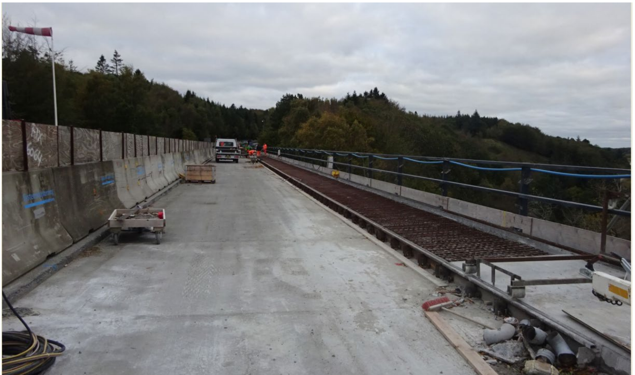
Sallingsundbroen set fra S – udførelse af kørebaner og fortov
