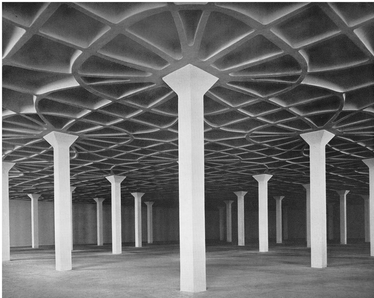
Materialebesparende betondæk designet af betonpioneren Pier Luigi Nervi i 1920'erne
