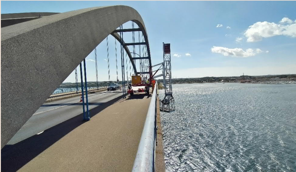
Langelandsbroen - Traditionelt generaleftersyn af underside buefag.
