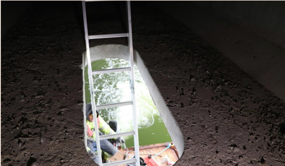
Hadsundbroen – Adgangsforhold til inderside af brodrager.
