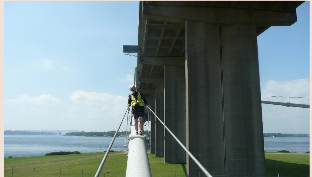
Ny Lillebæltsbro – Inspektion af hovedkabler.
