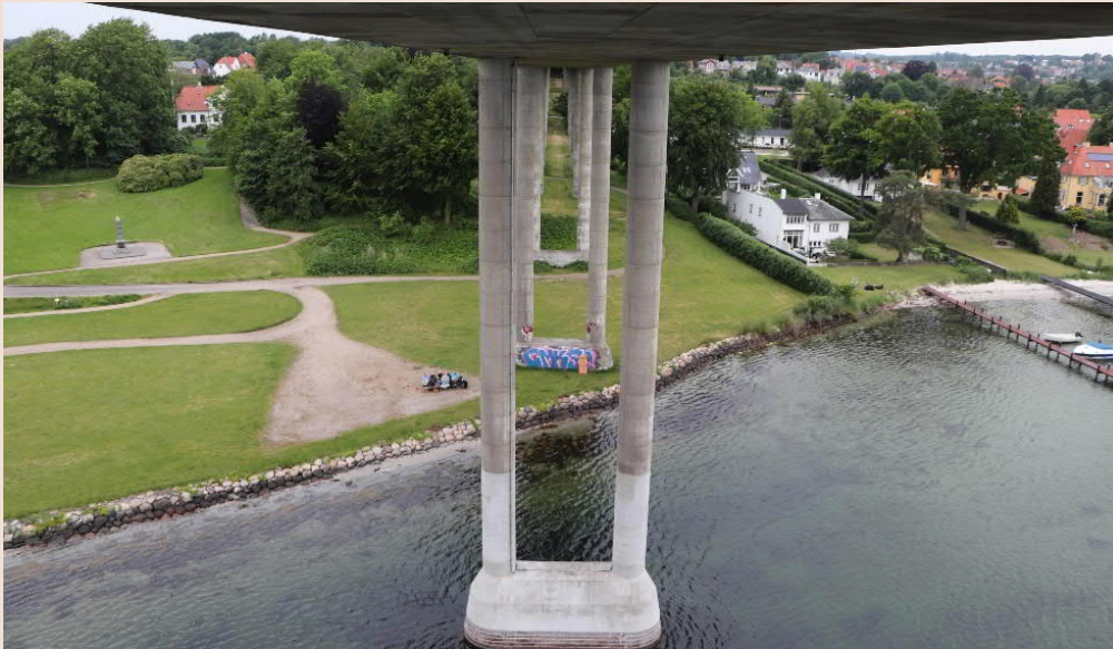
Svendborgsundbroen – Set fra underbroslift ved eftersyn.
