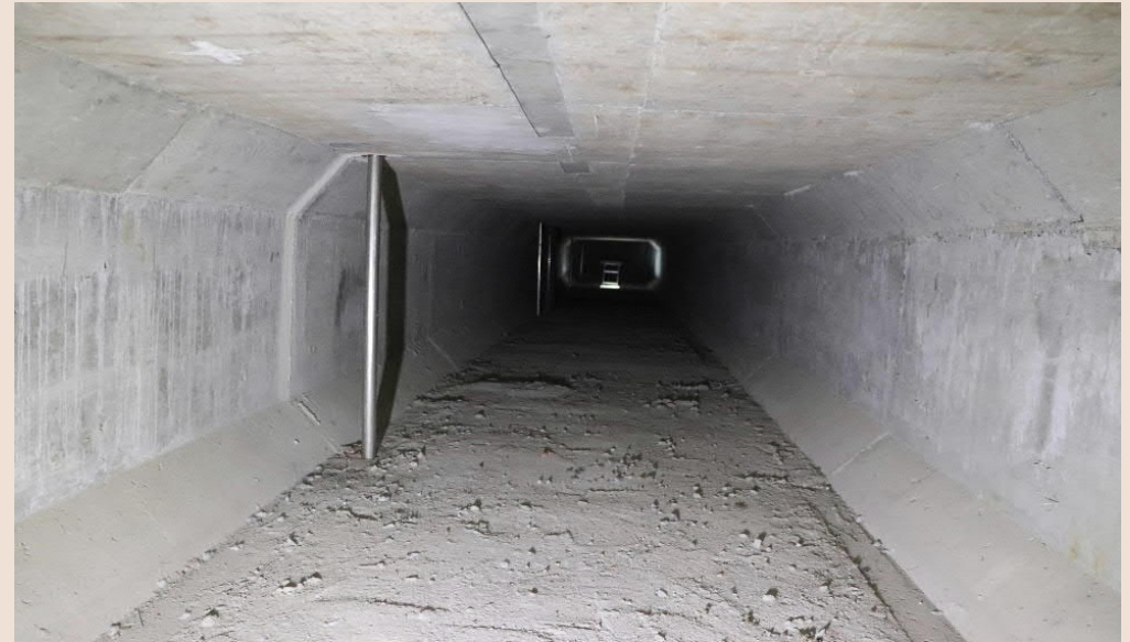
Hadsundbroen – Indvendig celle i brodrager.
