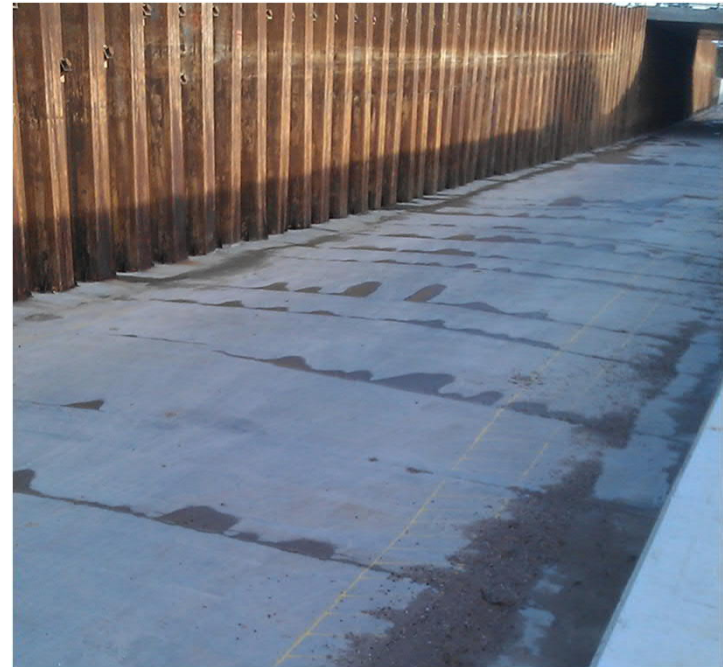
Geometrisk fastholdelse af bundplade i vægge
