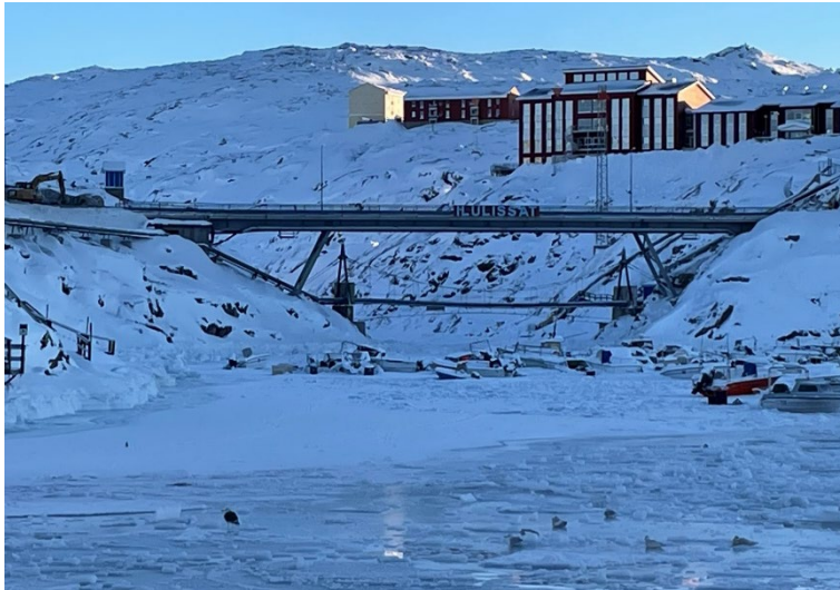
Figur 3: Broen i Ilulissat. Bemærk i øvrigt rørbroen i baggrunden udført som en hængebro.
