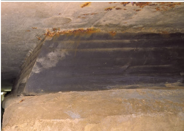
Foroven: Ældre stållejer Forneden tv.: Ældre elastomerleje Forneden th.: Nyere elastomerleje
