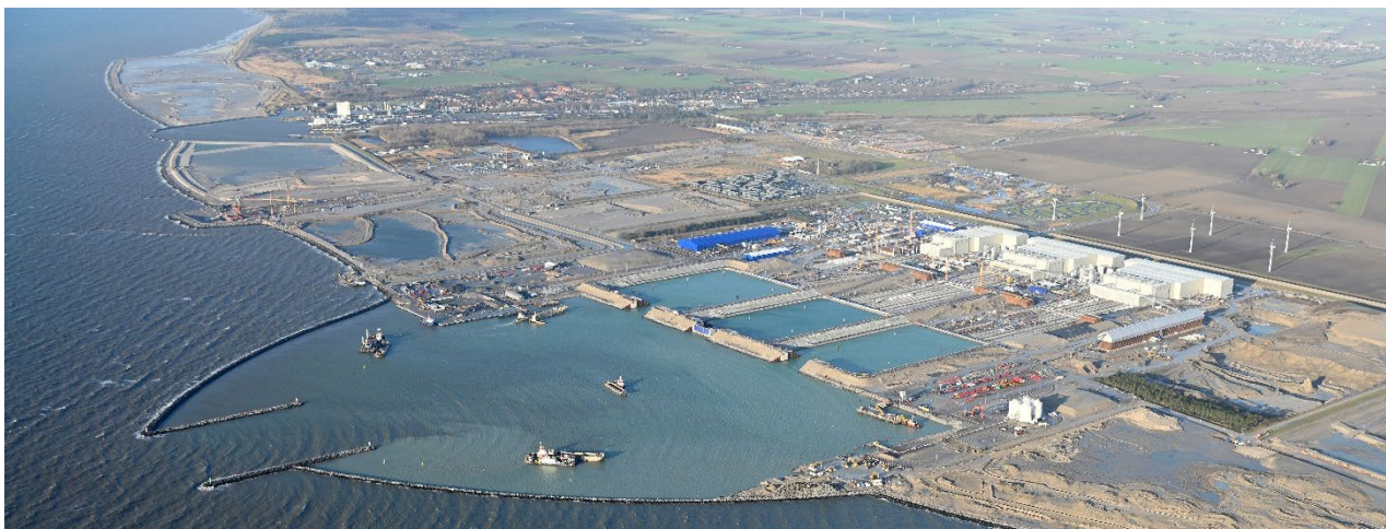
Tunnelfabrikken ved Rødbyhavn med arbejdshavn.
