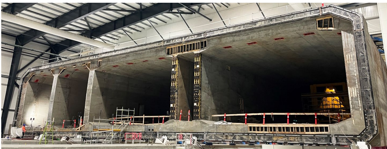
Et færdigt tunnelsegment. Et standardtunnelement på ca. 217 meter støbes i 9 segmenter.
