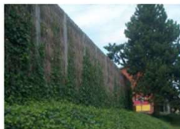
Støjskærm med barket pilefacade og beplantning
