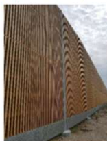
Støjskærm med træbeklædning
