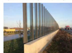
Støjskærm med aluminiumssøjler og akrylplader
