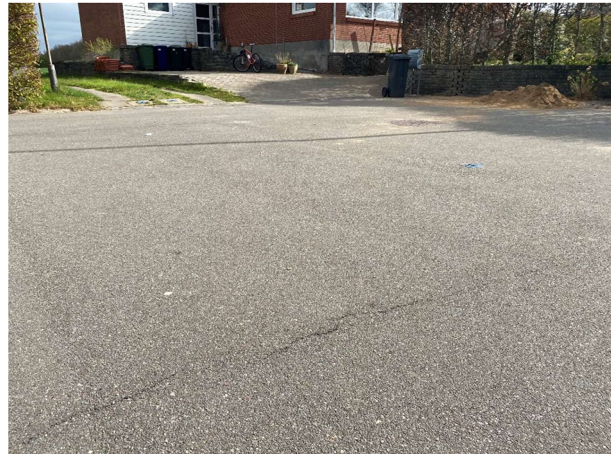
2022 – sidevej uarmeret med store revner
